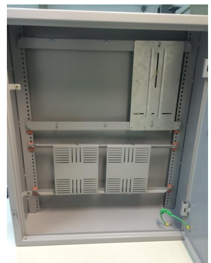
Figura 3 – EXEMPLOS DE APLICAÇÃO DA PLACA DE FIXAÇÃO DO MEDIDOR (FORNECIDO PELA AES ELETROPAULO)
