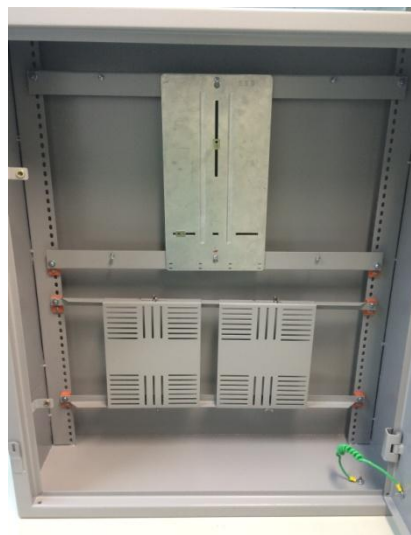
Figura 3 – EXEMPLOS DE APLICAÇÃO DA PLACA DE FIXAÇÃO DO MEDIDOR (FORNECIDO PELA AES ELETROPAULO)
